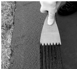
Billede 4: Enkolit® påføres med tandspartel
