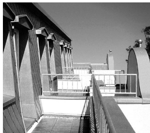
Billede 15: Anvendelse af RHEINZINK-bygningsprofil som muraf-dækning
