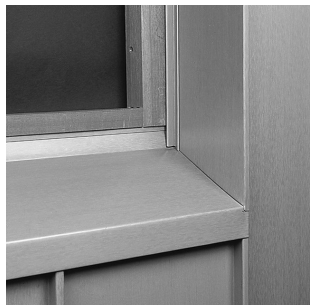
Billede 15: Samling mellem sideinddækning og sølbænk
