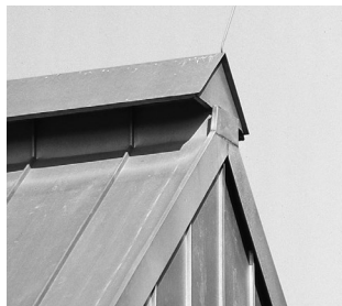
Billede 8: Rygningsafslutning ved vindske, høj udførelse
