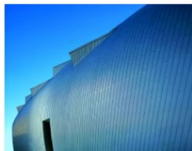
De mange smukt patinerede zinkbaner får nyt liv i et andet byggeprojekt.
