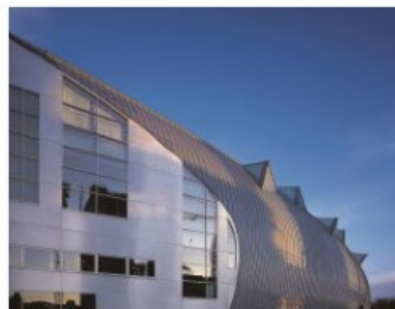
Kiasma-Museet i Helsinki, bygget i slutningen af 90-erne.
