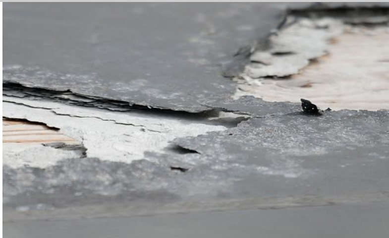
Zink monteret direkte på krydsfiner (5 år)
