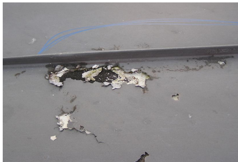
Zink monteret direkte på krydsfiner (5 år)
