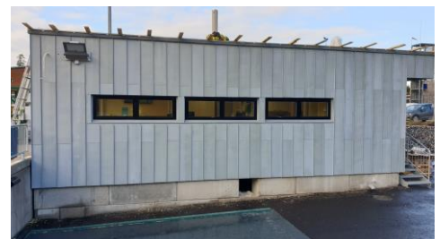
Ny zinkfacade monteret med genanvendt RHEINZINK fra Kiasma.
